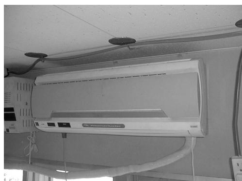
**写真1** エアコンに火災感知器を組み込んだシステム
