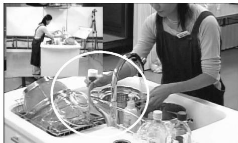
図13 水切りカゴに入れた食器が水栓レバーと干渉している様子
